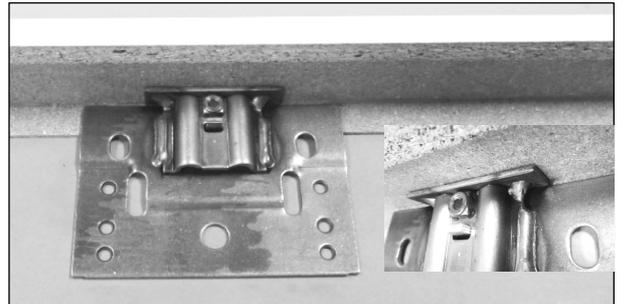
Bandtaschen ST84-AS-neu auflegen und bis zum Anschlag gegen die Bekleidung schieben, so dass die Führungshülsen mit dem Zargenspiegel weitestgehend bündig sind.
