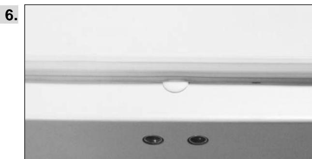
Die Verschraubung wird nach dem Einziehen der Dichtung komplett bzw. weitestgehend überdeckt.
