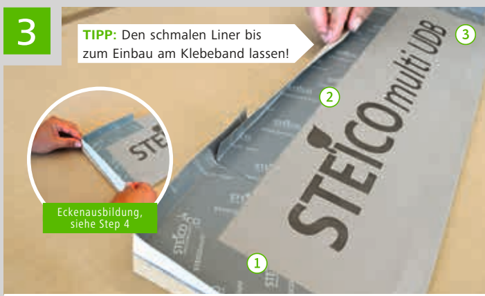
3 TIPP: Den schmalen Liner bis zum Einbau am Klebeband lassen! Im Anschluss die STEICO multi tape F 20/40 mm Klebestreifen so auf dem Dämmkeil anbringen, dass eine dreiseitige „Wanne“ ausgebildet wird
