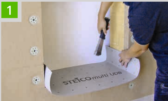
1 Anbringen der diffusionsoffenen Unterdeckbahn STEICO multi UDB als temporärer Witterungsschutz bis zum Einbau
