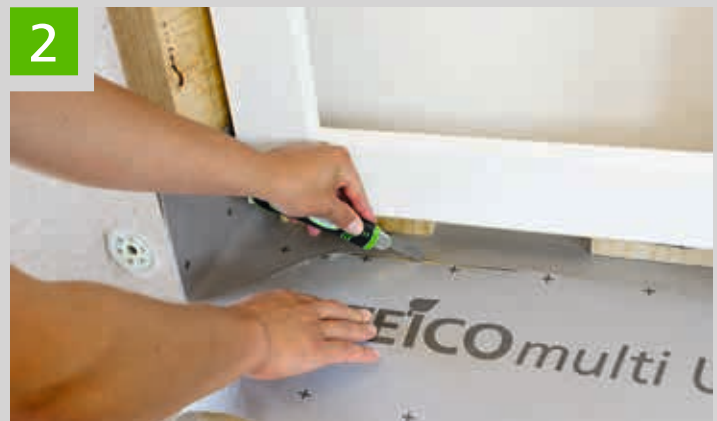
2 Der Fenstereinbau erfolgt auf der Unterdeckbahn. Vor Montage von STEICO fix die Bahn trapezförmig zurückschneiden (vgl. Bild 5)
