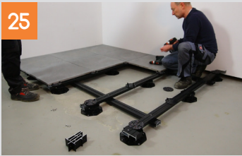
Verlegen der Platten in der Fläche
