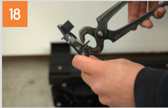
Montieren der M- und S-Fix im Randbereich
