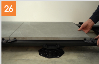
Verlegen der Platten in der Fläche
