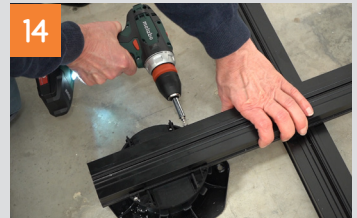
Terrassenlager mit Schienen verschrauben und Wand-Fix setzen
