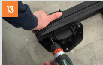
Terrassenlager mit Schienen verschrauben und Wand-Fix setzen
