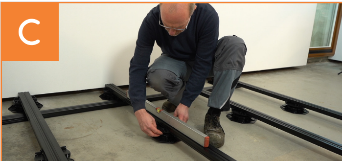
Unterkonstruktion in der Höhe ausrichten und mit der Konterlattung verschrauben
