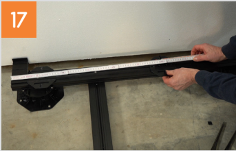
Montieren der M- und S-Fix im Randbereich
