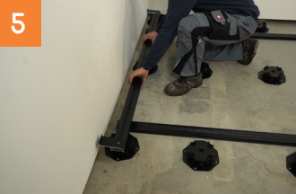
Schiene aufklicken und Abstände auf Plattenbreite ausrichten
