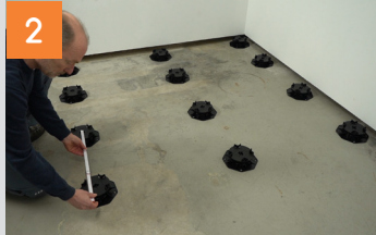
Terrassenlager aufstellen und Konterlattung auslegen
