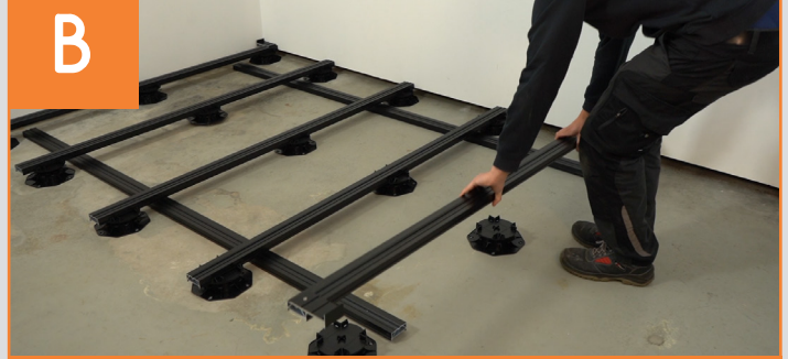
Schiene aufklicken und Abstände auf Plattenbreite ausrichten
