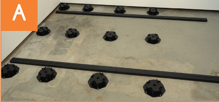
Terrassenlager aufstellen und Konterlattung auslegen
