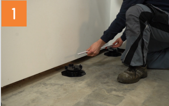
Terrassenlager aufstellen und Konterlattung auslegen
