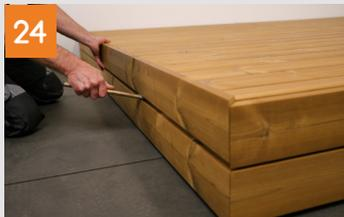
Es wird immer zuerst die oberste Q-LICK Diele nach oben ausgehebelt. Ist die z.B. Wartungsarbeit erfolgt, können die Dielen wie bei der Montage erneut eingeklickt werden.
