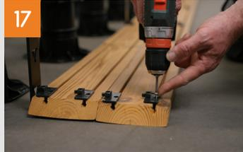
Nur in die jeweiligen Q-LICK Befestiger von der obersten Diele in die erste Nut wird die mitgelieferte Schraube 3,9 x 9,5 mm eingedreht. Sie dient damit als Auszugssicherung.
