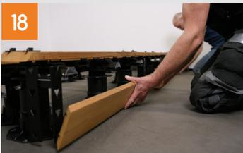
Eine Montage der Seitenverblendung erfolgt von unten nach oben. Dabei wird die Diele mit den Q-LICK Befestiger für die Seitenverblendung eingehängt und durch Druck von oben eingeklickt.
