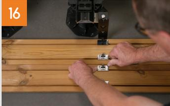
Die Positionierung der Q-LICK Befestiger für die Seitenverblendung erfolgt mittig zum Blendenhalter.
