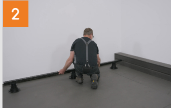
Konterlattung positionieren
