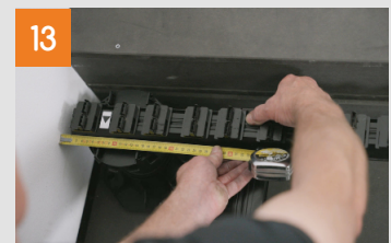
Erste Systemschiene positionieren
