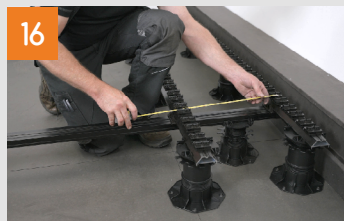
Systemschiene verlegen
