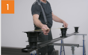
Konterlattung positionieren
