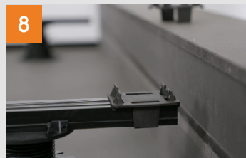
Erste Systemschiene positionieren
