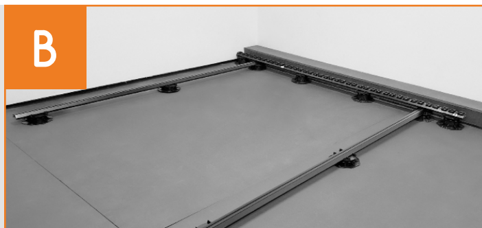
Erste Systemschiene positionieren
