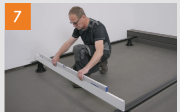
Konterlattung in Waage ausrichten
