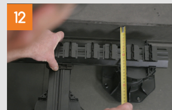
Erste Systemschiene positionieren
