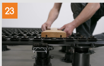
Erste und zweite Diele montieren
