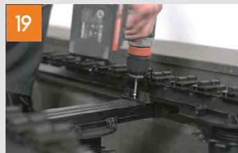
Ersten KL-Kreuzverbinder fixieren und Ausrichtung prüfen
