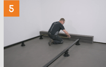
Konterlattung positionieren
