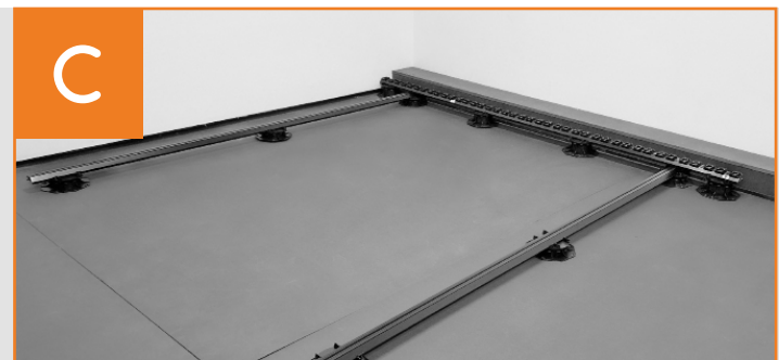
Erste Systemschiene positionieren
