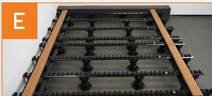
Erste und zweite Diele montieren
