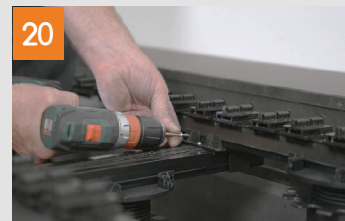
Ersten KL-Kreuzverbinder fixieren und Ausrichtung prüfen
