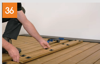
Diele herausnehmen und wieder einsetzen
