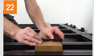
Montaggio del primo listone
