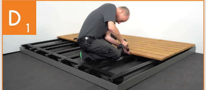
Installation des lames en surface
