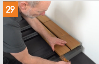
Montaggio dei listoni sulla superficie
