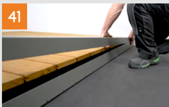
Finition des parements latéraux
