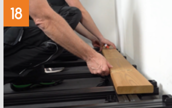
Montaggio del primo listone
