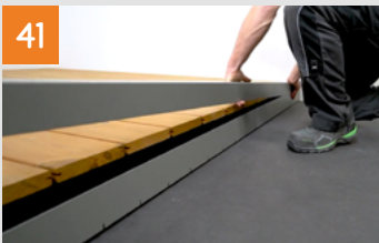
Fertigstellung der Seitenverblendung
