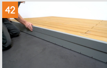
Fertigstellung der Seitenverblendung
