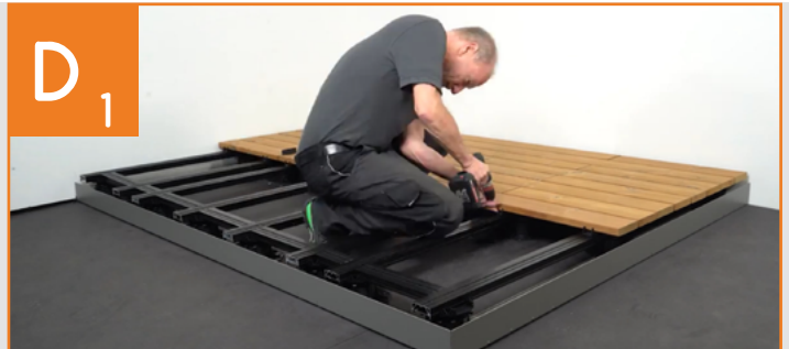
Montaggio dei listoni sulla superficie
