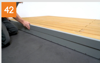
Finition des parements latéraux
