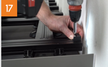
Montaggio del primo listone
