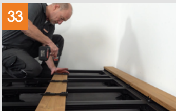
Montaggio dei listoni sulla superficie
