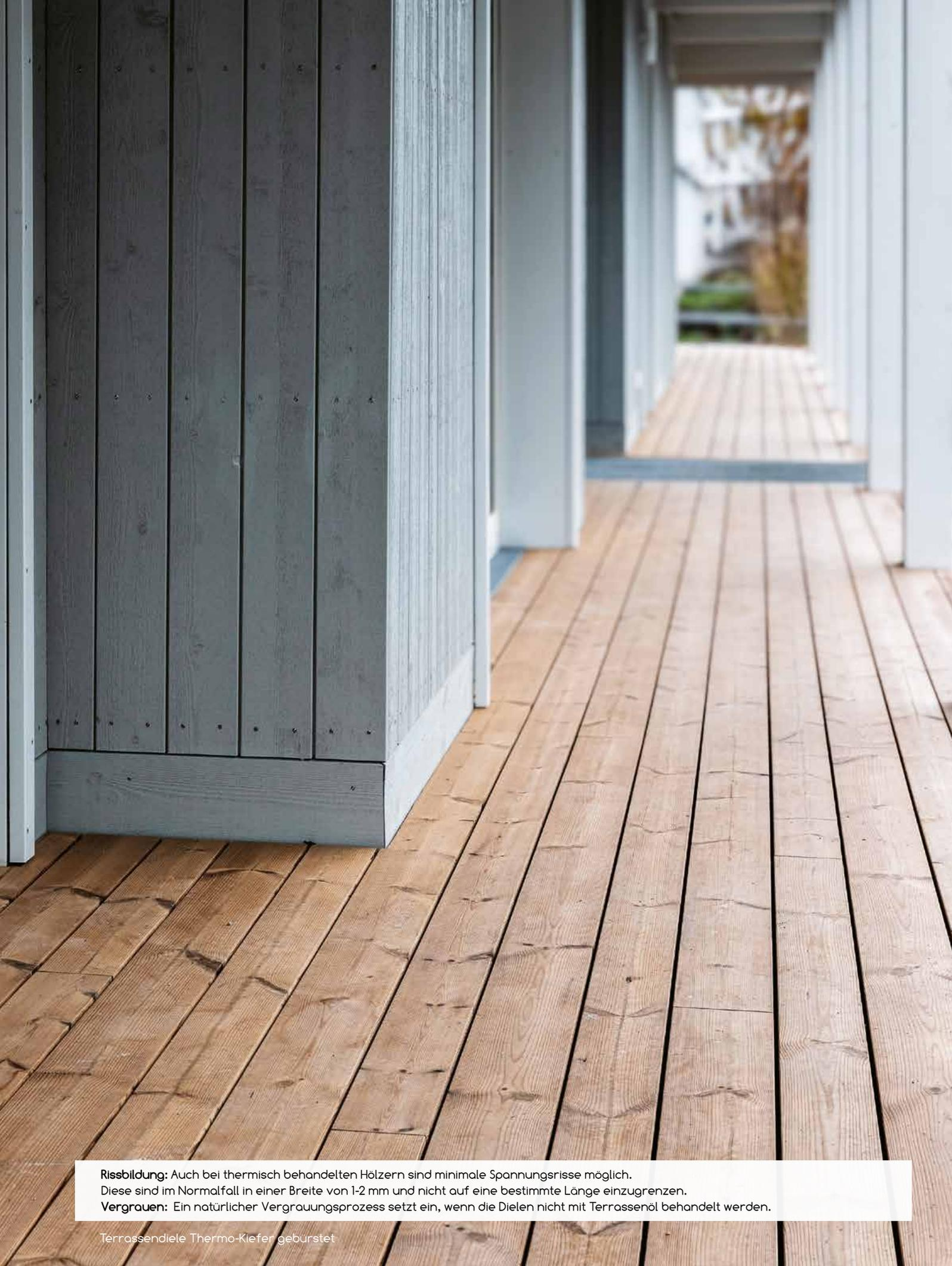
**Rissbildung:** Auch bei thermisch behandelten Hölzern sind minimale Spannungsrisse möglich. Diese sind im Normalfall in einer Breite von 1-2 mm und nicht auf eine bestimmte Länge einzugrenzen.
