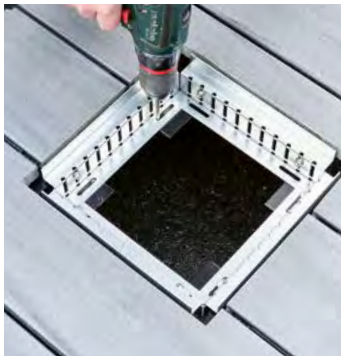
Revisionskasten einsetzen und an Windlastträger verschrauben
