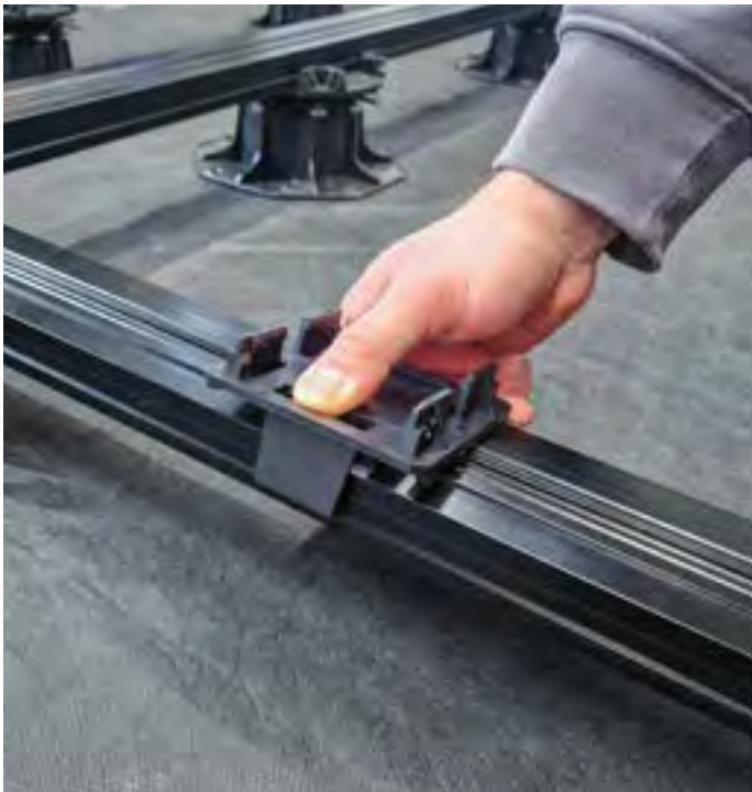
KL-Kreuzverbinder auf die ausgerichtete Konterlattung einklicken
