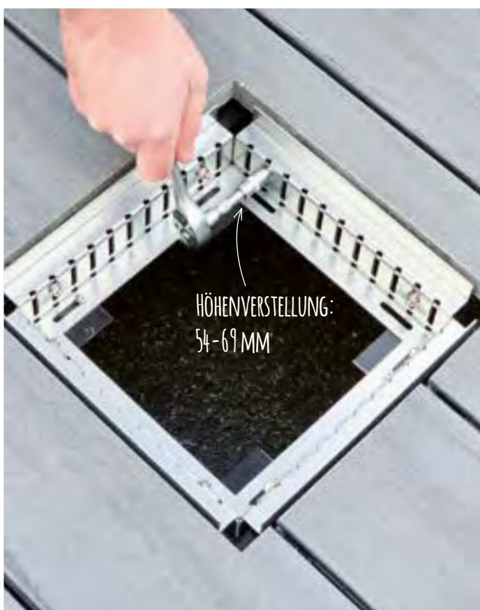
Höhe des Revisionskastens an den Terrassenbelag anpassen
