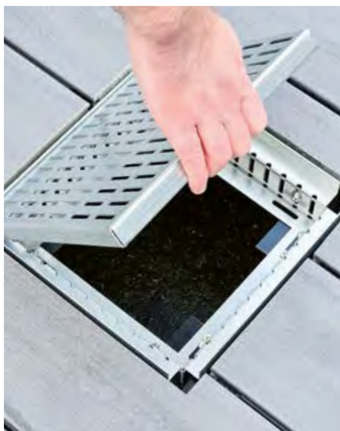
Abdeckblech in den montierten Kasten einlegen
