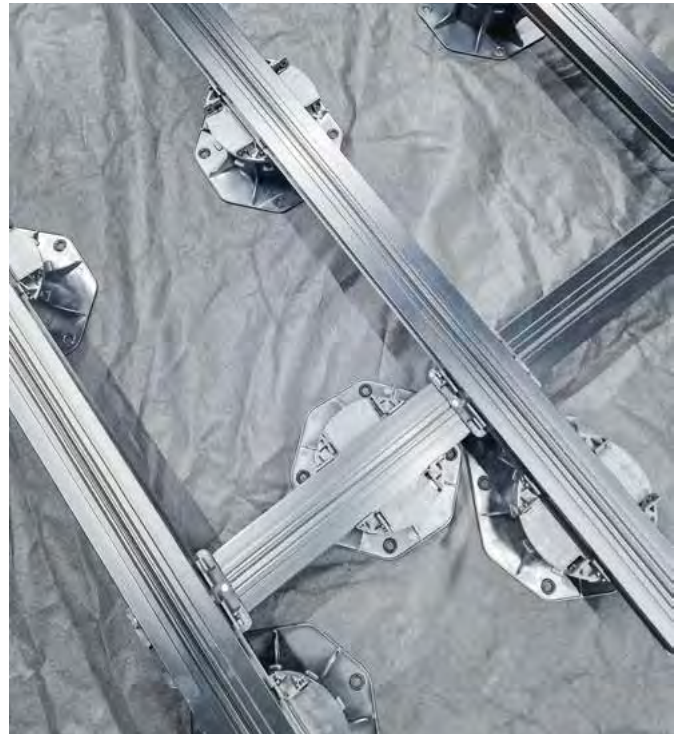
Konstruktion mit doppelter Unterkonstruktion am Anfang und Ende
