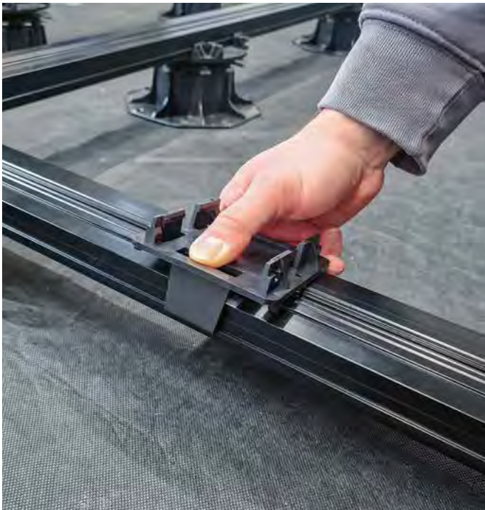
KL-Kreuzverbinder auf die ausgerichtete Konterlattung einklicken
