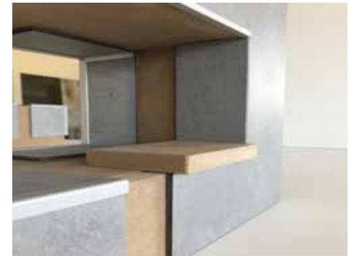
NISCHE ODER FENSTERLAIBUNG SEITLICH GEKANTET, OBEN MIT ABSCHLUSSPROFIL UNTEN MIT ABDECKPLATTE
